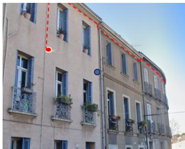
Figure 4 Exemples de cheminement de câble éclairage public
