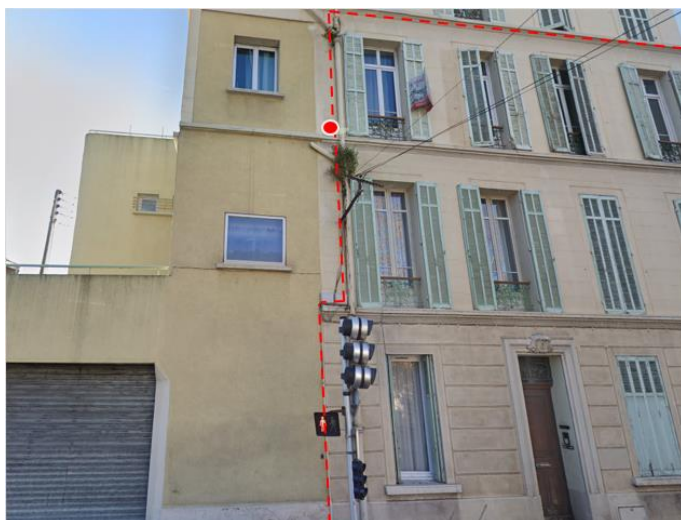
Figure 4 Exemples de cheminement de câble éclairage public
