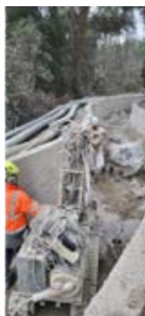
Mise à sec du tronçon et atelier de micropieux
