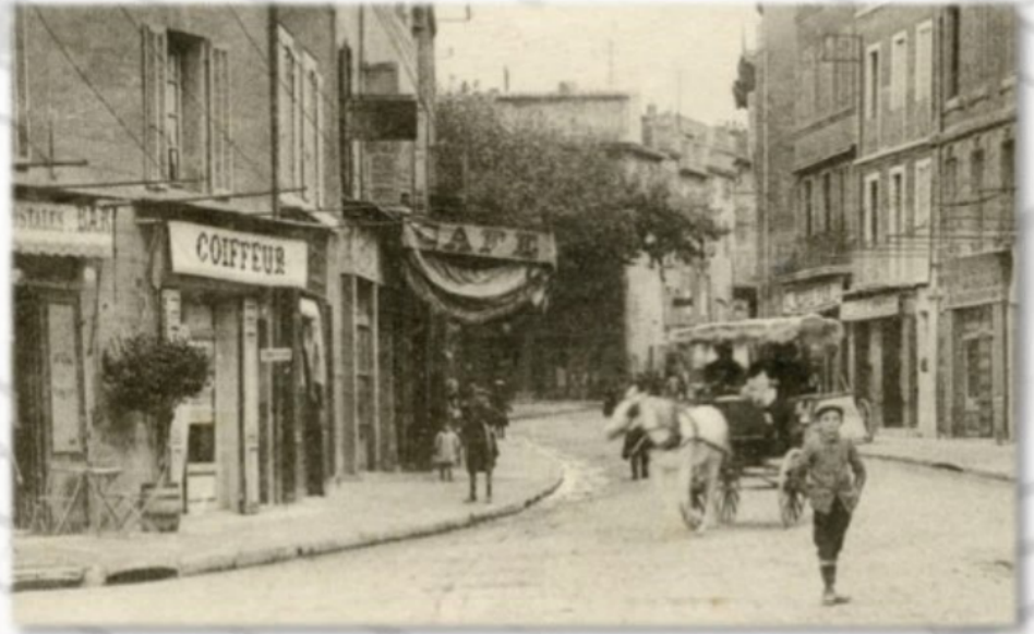
L'ancien emplacement du Grand Bar © AMA, 20 Fi 323
