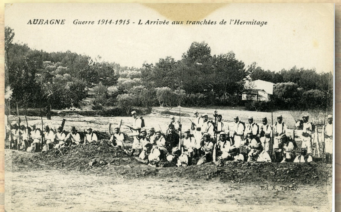
Une tranchée dans Aubagne pour l'instruction des soldats © DR, AMA 20 Fi 131
