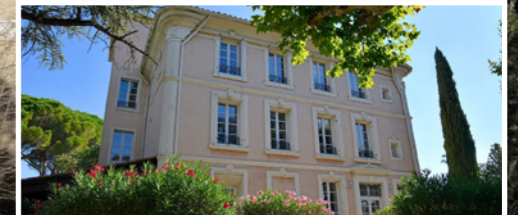
Depuis 1978, la bastide de La Gauthière est la propriété de l'Association régionale d'aide aux infirmes moteurs cérébraux (ARAIMC) qui y a implanté un établissement de service d'aide par le travail (ESAT).
