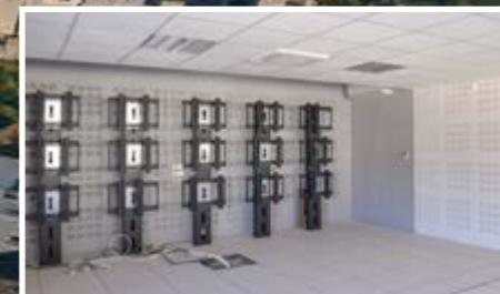
Le chantier du futur Hôtel de Police municipale est piloté par la Mission travaux neufs.
